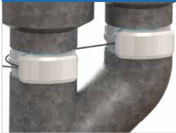
Montage in het kanaal
