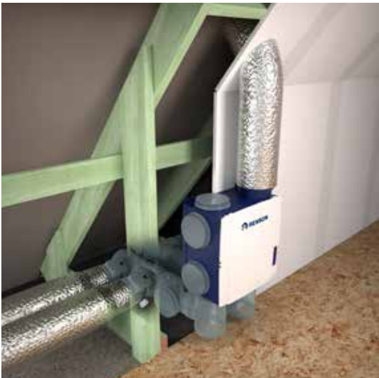
Luchtkanalen netjes wegwerken in de verloren driehoek
